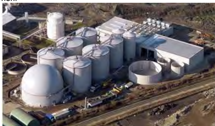
Afbeelding 3: Grootschalige vergister Lijnco Green Energy te Sluiskil
