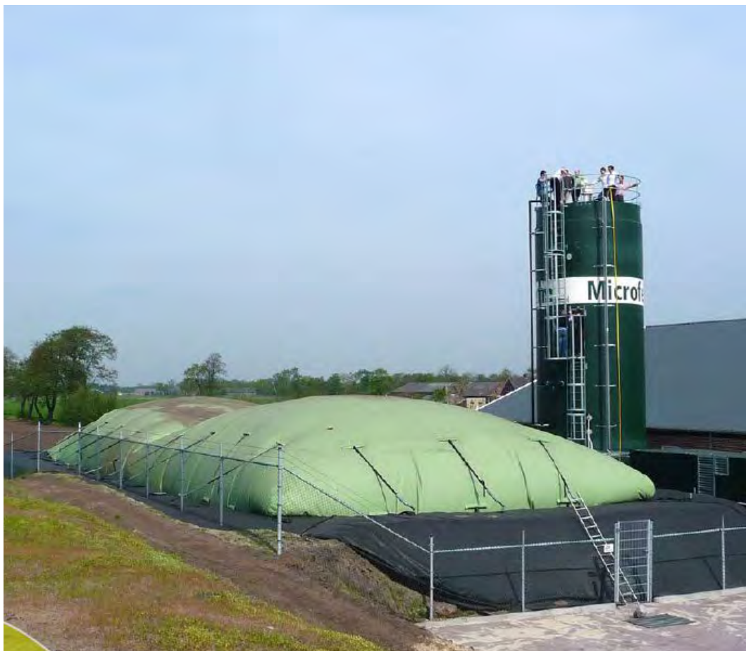
Afbeelding 2. De kleinschalige boerderijvergister bij VOF Kleizen te Langeveen
